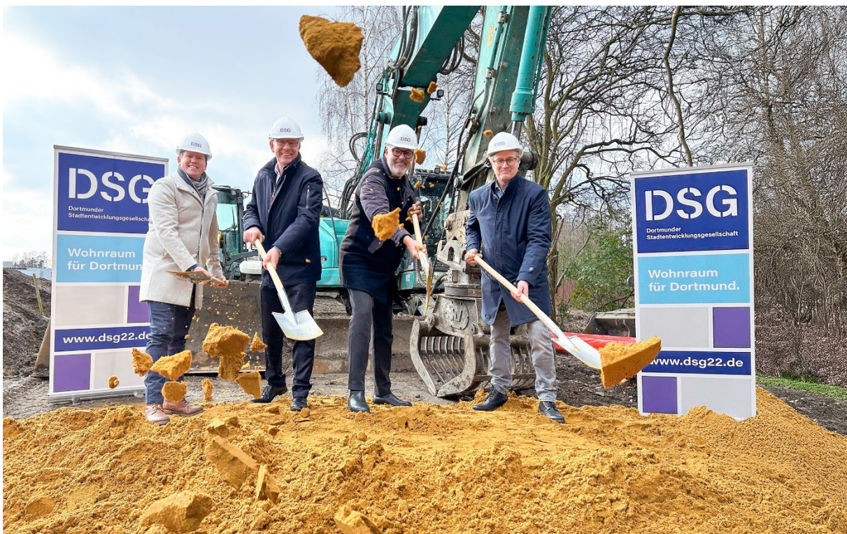
Spatenstich Stettiner Straße 2-6 ©DSG
